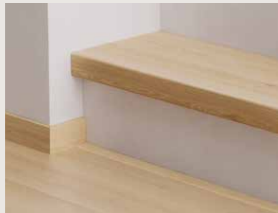
MAALATTUJEN ASKELMIEN AENNUS Asenna vain askelmat ja maalaa loput samanväriseksi kuin seinä.
